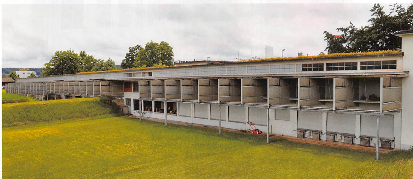
Stand des 300m à Ohrbühl près de Winterthur
